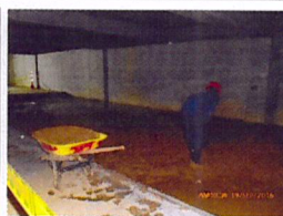
Retiro de material saturado e n sotano 2
