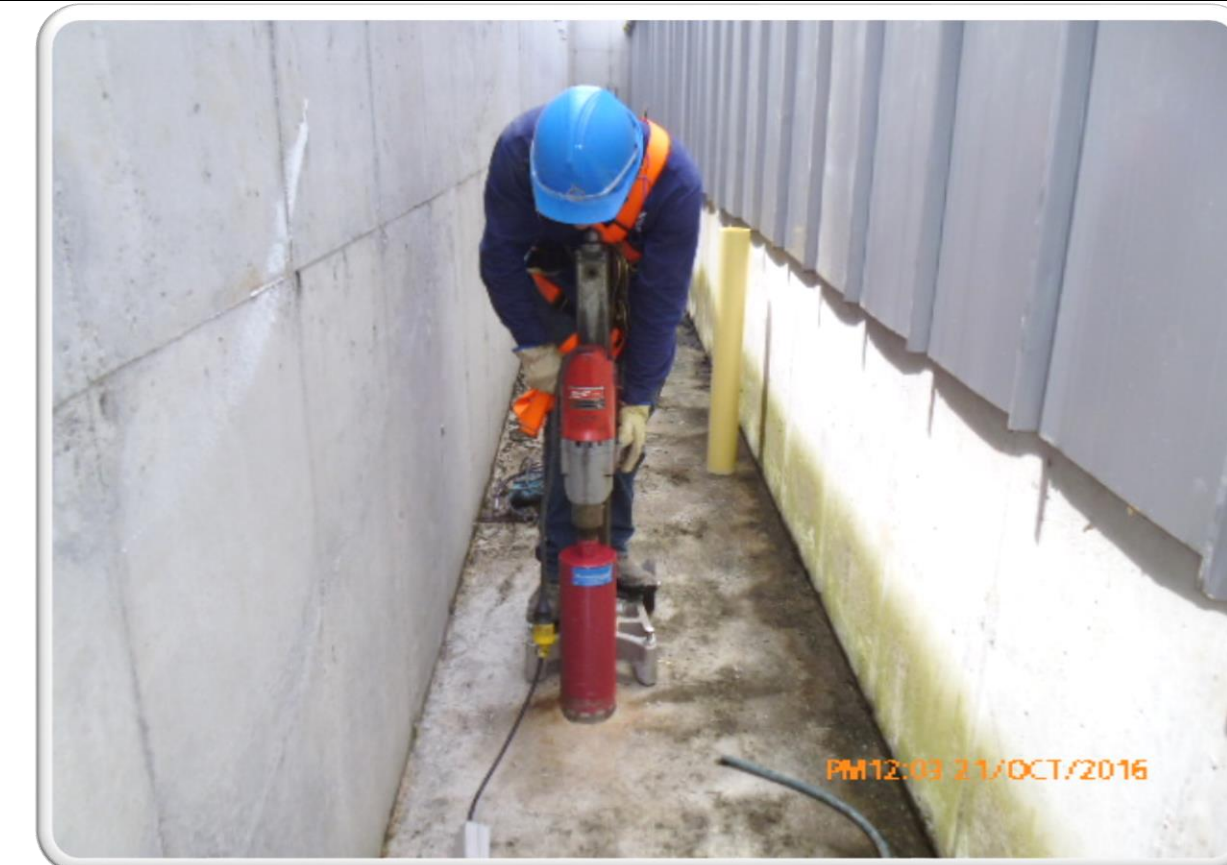
Perforación para bajantes de aguas lluvias 3048
