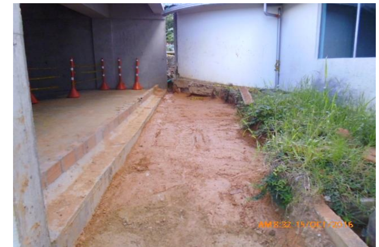
Relleno y compactación sector de la transición-sótano 1
