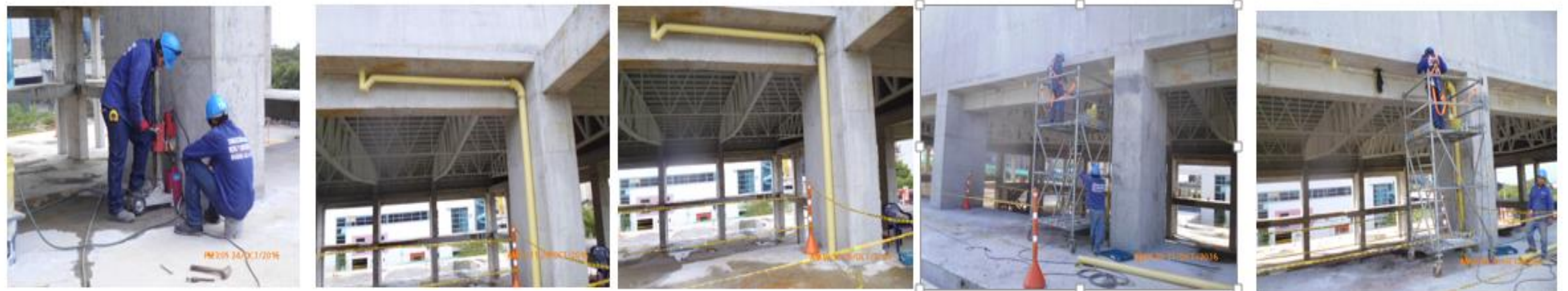
Instalación de sifones y bajantes de aguas lluvias
