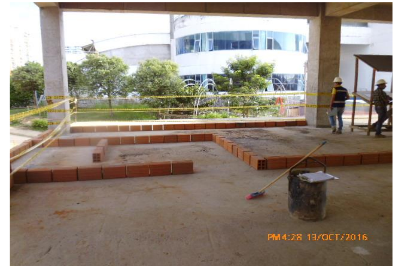
Replanteos iniciales de mampostería
