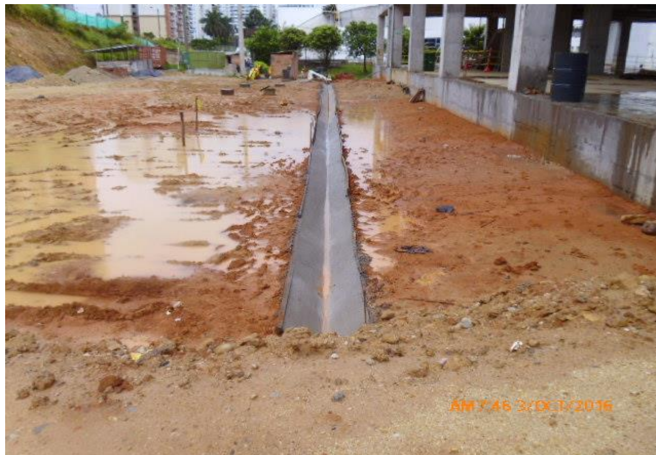
Para manejo de aguas lluvias construcción de canaleta costado oriental
