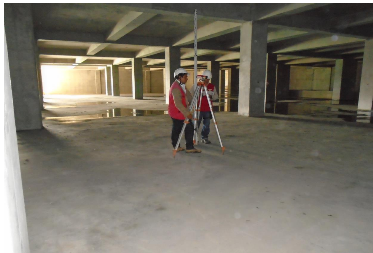
Demarcación de punos para control de deflexiones
