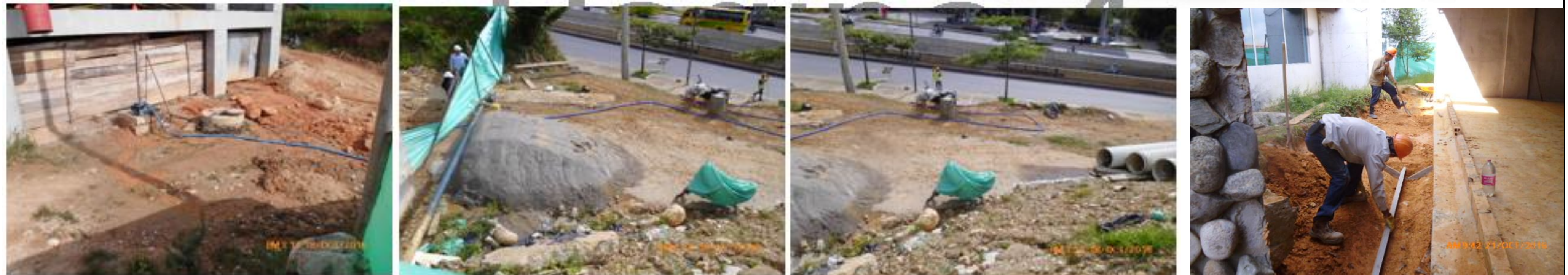
Excavación para cuneta aguas lluvias
