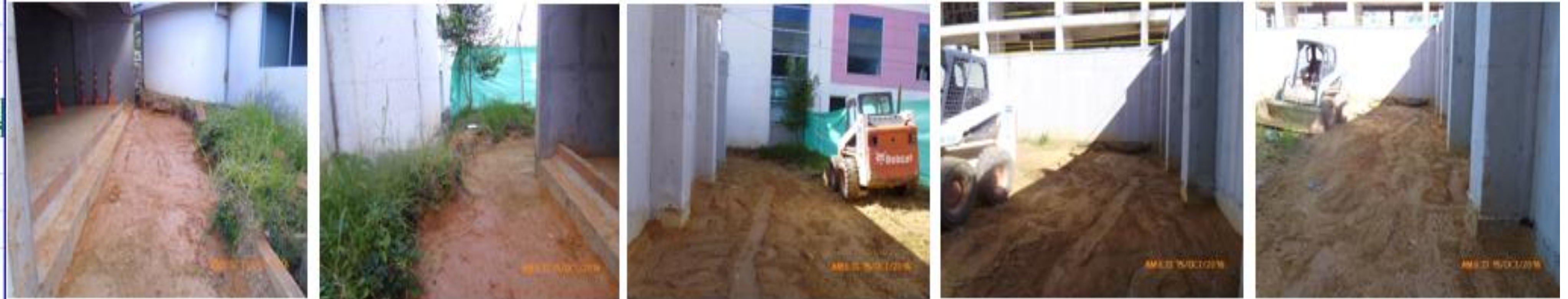
Acondicionamiento de terreno para evacuación de aguas superficiales costado oriental y sur
