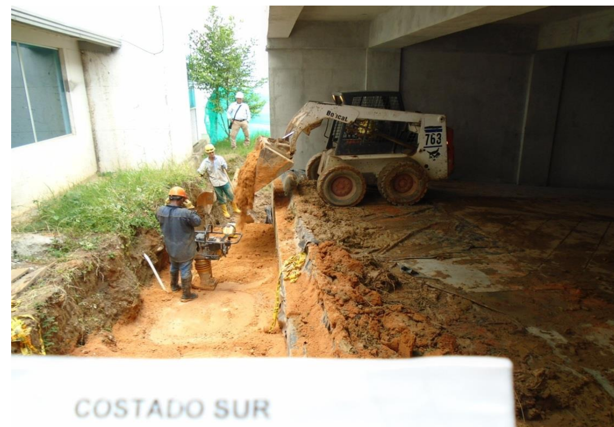
Relleno y compactación sector de la transición-sótano 1
